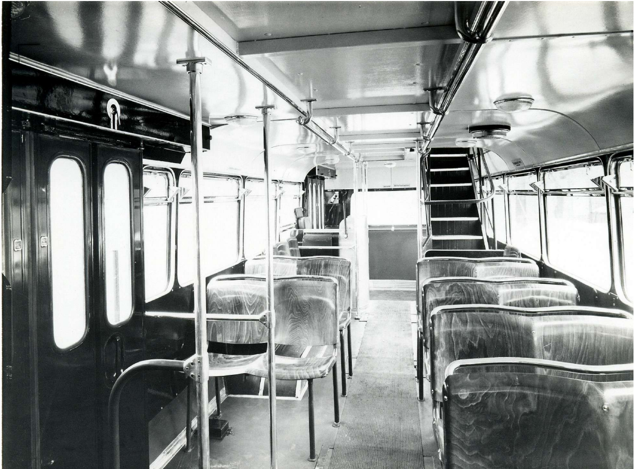
Unter- und Oberdeck des Obus 331. Über 100 Fahrgäste konnten mitfahren. 25 Sitze im Unterdeck und 37 Sitzplätze im Oberdeck, sowie 41 Stehplätze im Unterdeck standen zur Verfügung. Wie bei der Straßenbahn kamen Durofol-Bestuhlung zum Einbau. Foto: HHA
