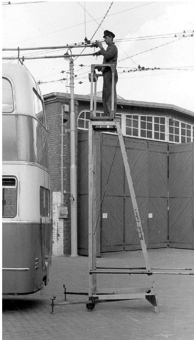
Betriebshof Harburg: Auswechseln der Kohlschleifstücke am Obus 334. Foto: HHA
